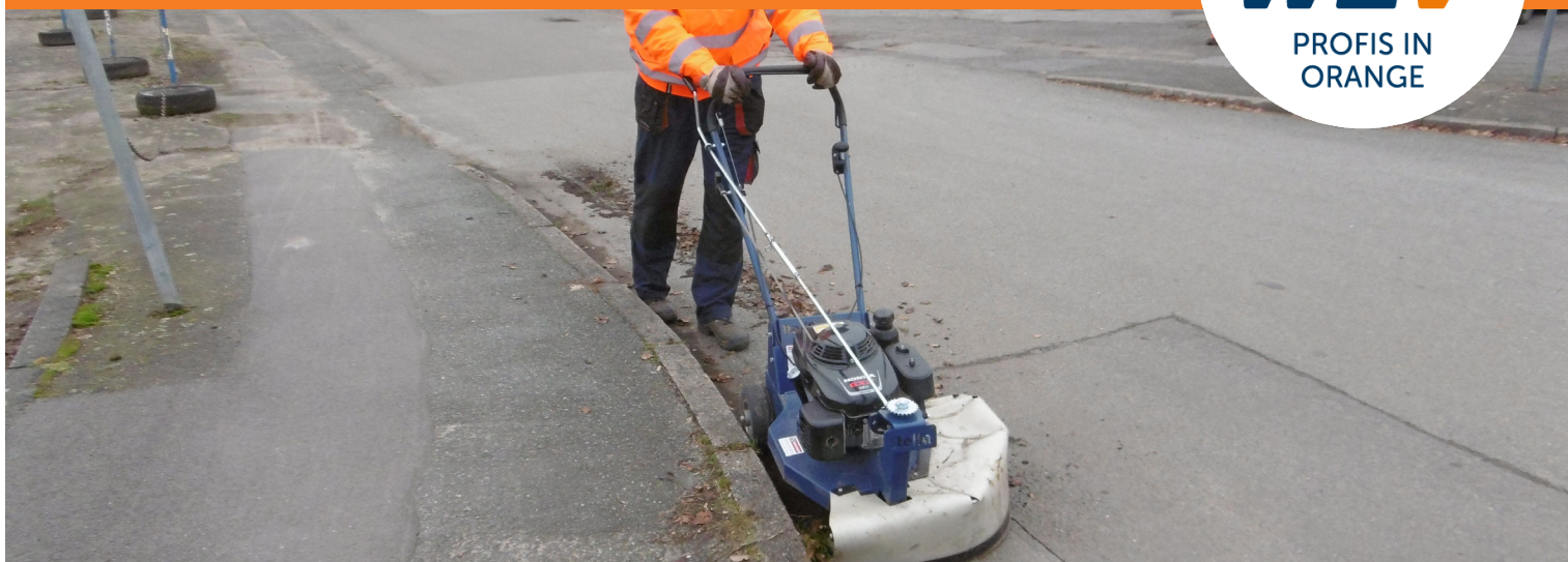
Reinigung des Hochbordes (ca. 500 Meter pro Tag)
