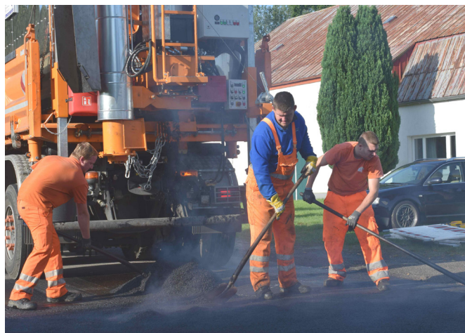
Dosierung und Positionierung des Asphaltgemisches
