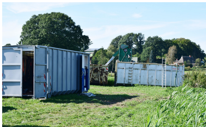
Vorlagecontainer mit Siebrechen
