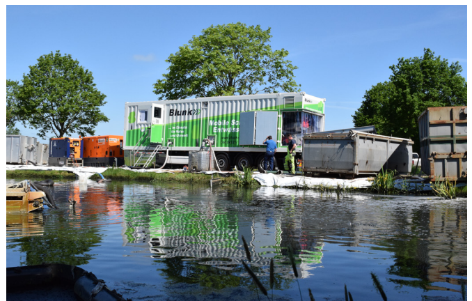
Mobile Entwässerung vor Ort
