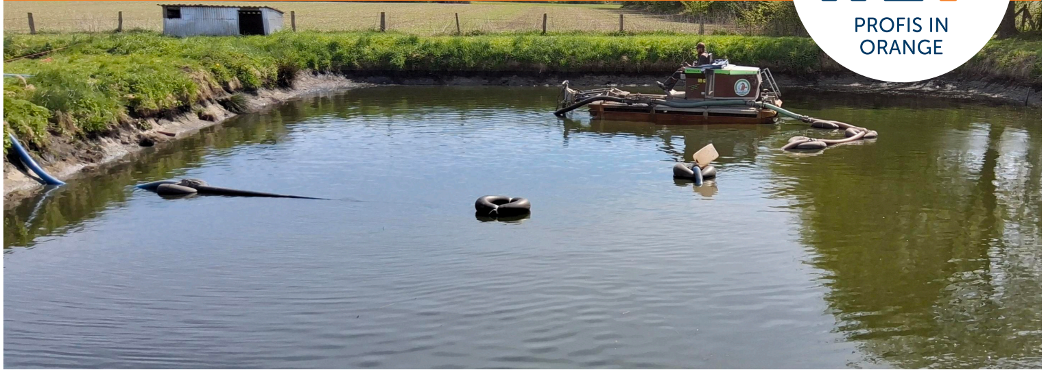
Absaugen des Klärschlammes mittels Amphibienboot
