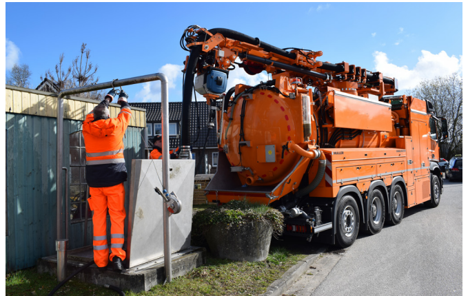
Kanalspüler bei der Reinigung einer Pumpstation
