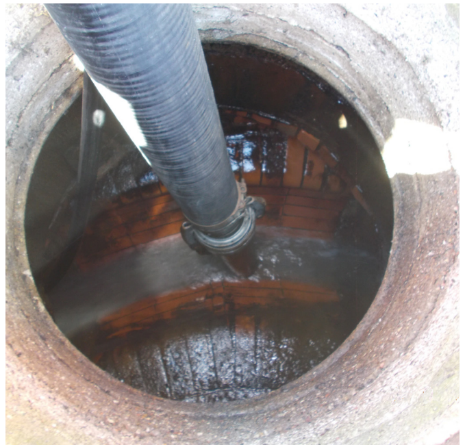
Blick von oben in den Schacht
