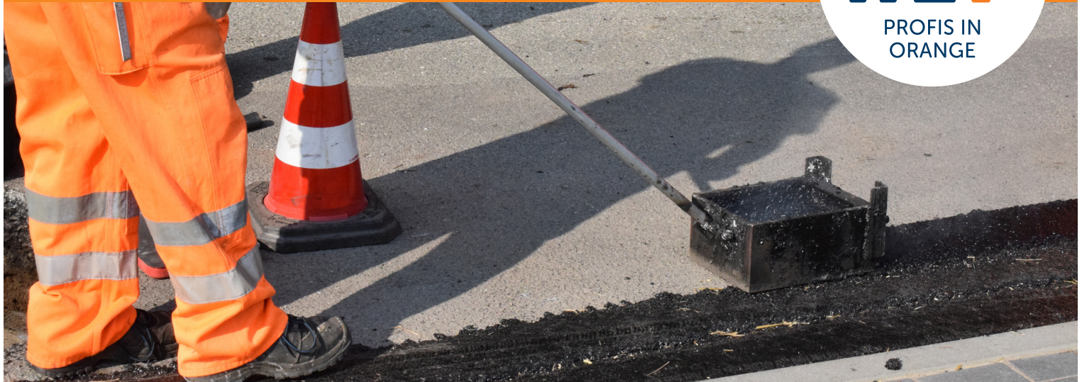
Aufbringung von Gussasphalt
