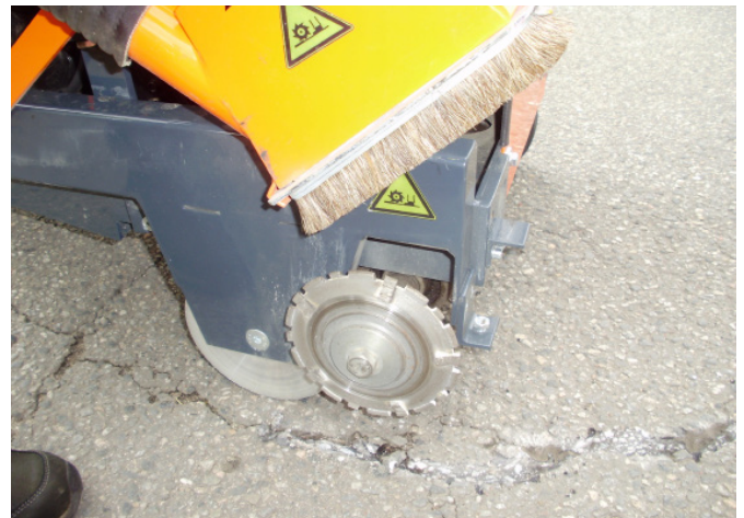
Fugenfräse im Einsatz
