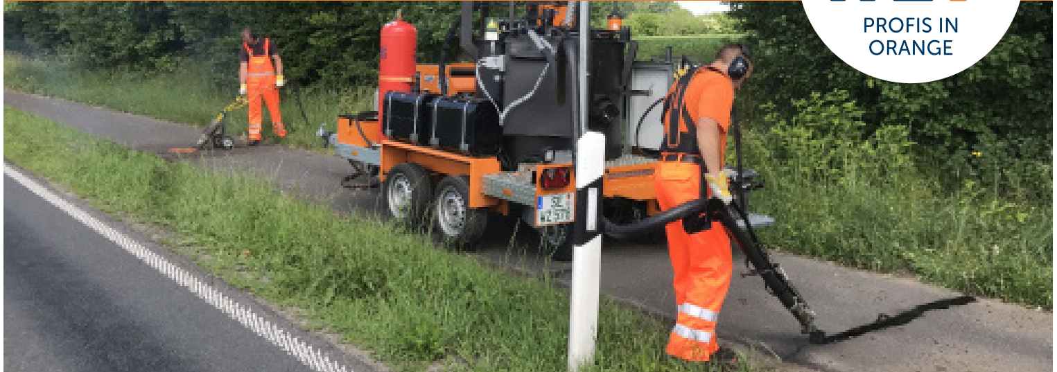
Zeitgleiches Ausblasen und Auffüllen des Risses
