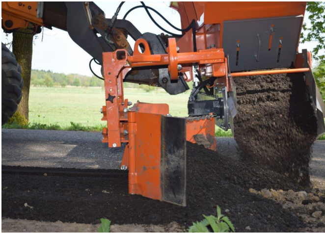
Material aufbringen und verteilen in einem Arbeitsschritt
