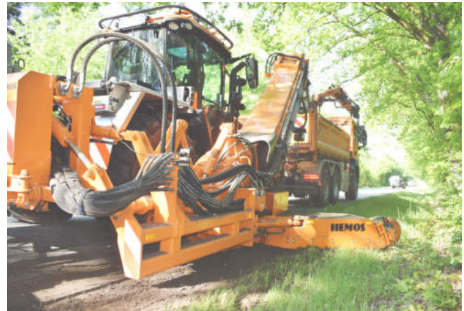
Bankette fräsen und Material aufnehmen in einem Schritt
