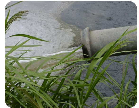
Gereinigtes Filtratwasser fließt zurück in den Klärteich
